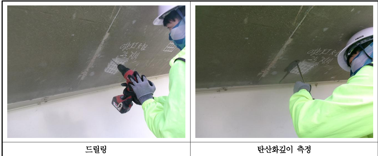
【사진 42.4.3】 탄산화 깊이 측정 현장사진
