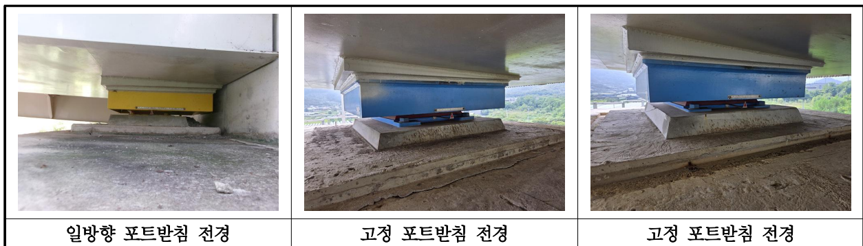
【사진 42.3.12】 교량받침 전경
