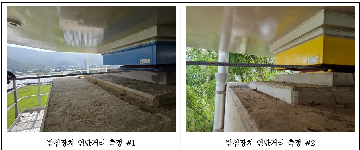
【사진 42.3.14】 교량받침장치 연단거리측정
