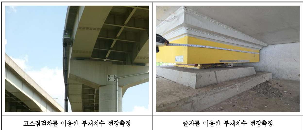
【사진 42.2.1】 부재 현장측정 전경
