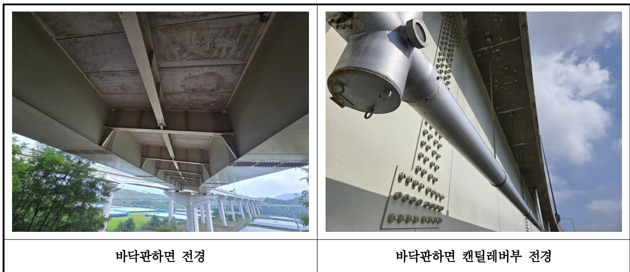
【사진 42.3.2】 바닥판하면 전경
