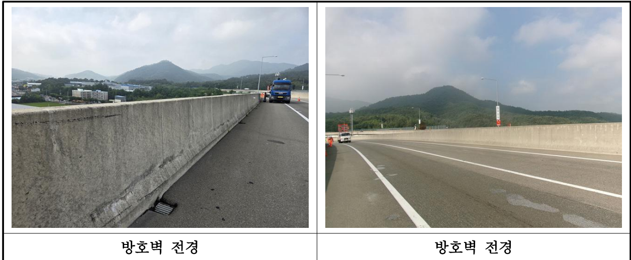
【사진 42.3.23】 방호벽 전경
