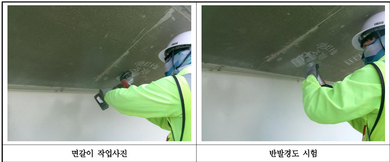
【사진 42.4.2】 반발경도시험 현장사진
