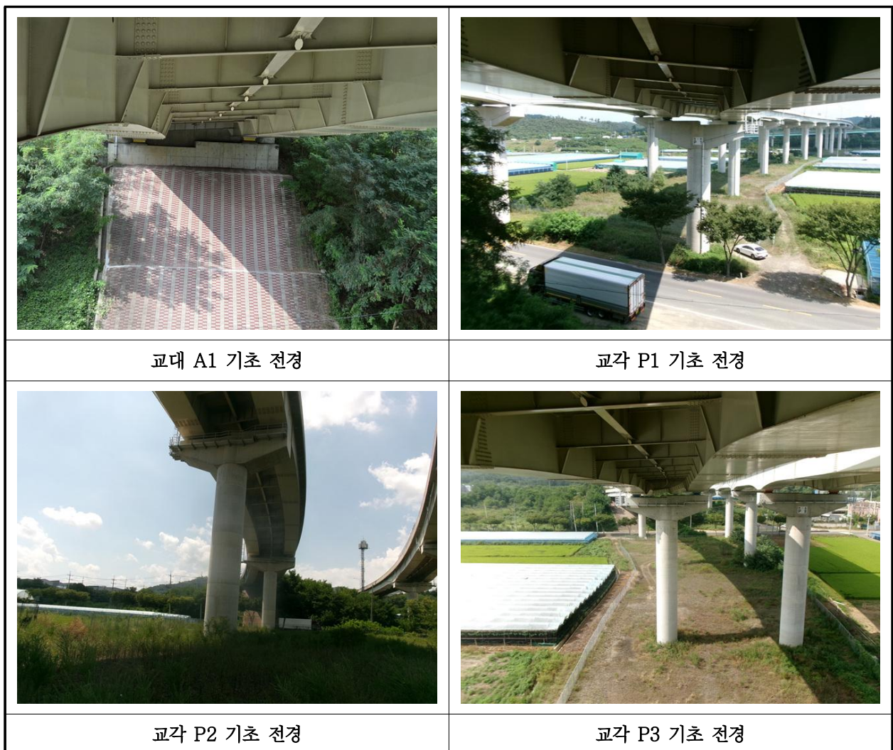
【사진 42.3.12】 기초 전경
