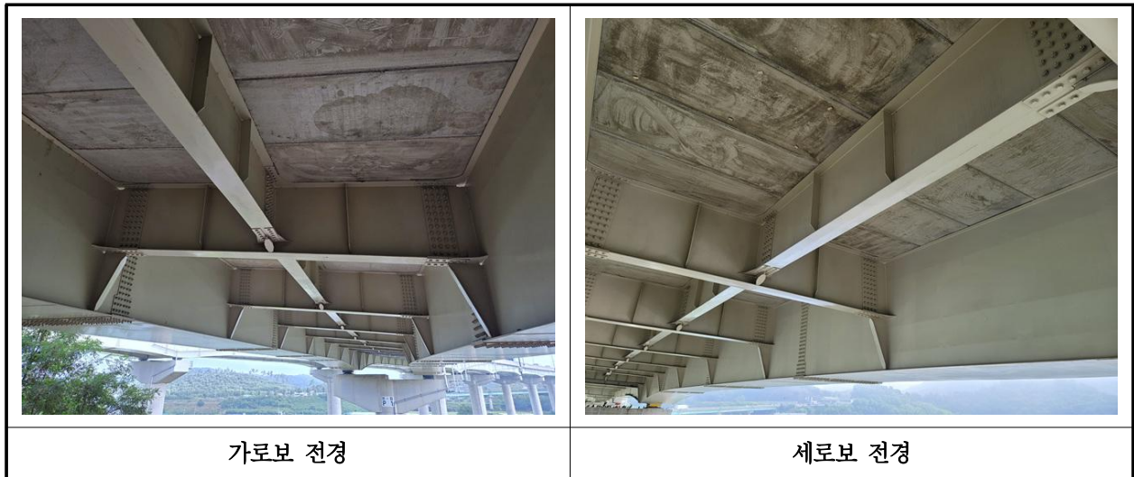
【사진 42.3.6】 가로보 및 세로보 전경
