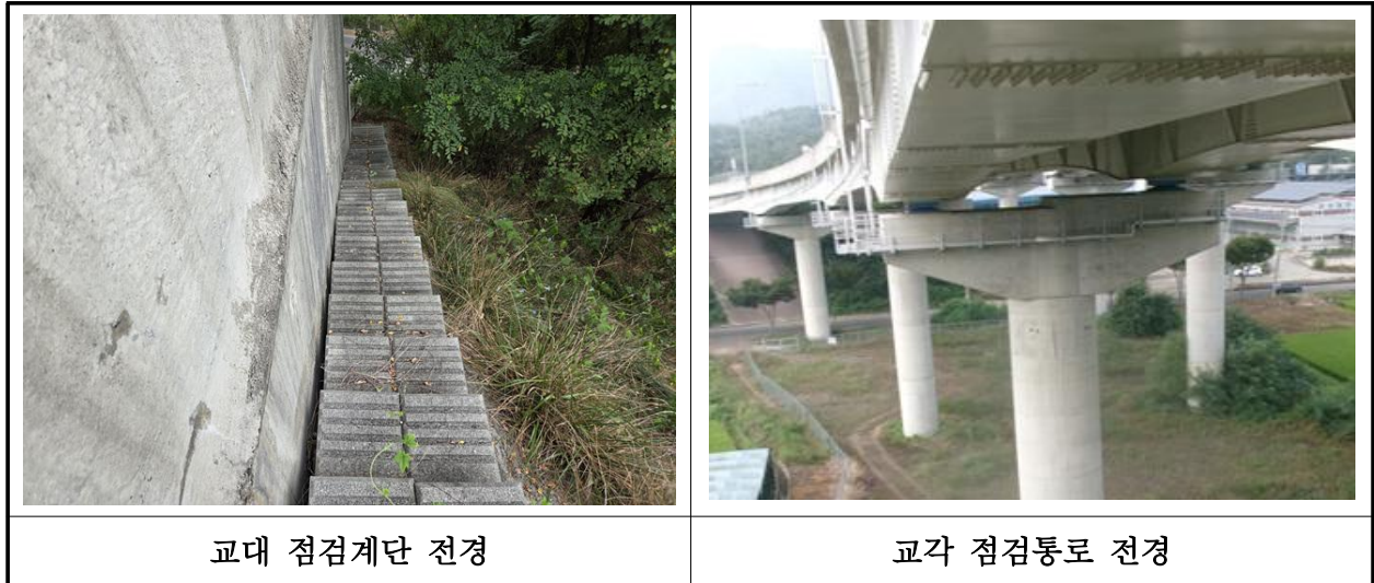
【사진 42.3.25】 교량 점검시설 전경
