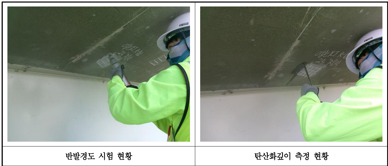
【사진 42.4.1】 콘크리트 내구성조사 현황
