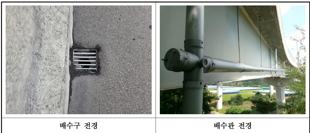
【사진 42.3.21】 배수시설 전경
