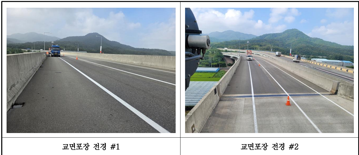
【사진 42.3.19】 교면포장 전경
