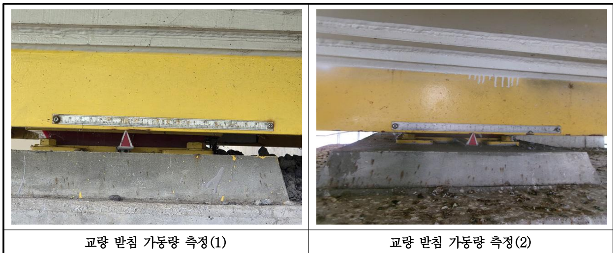
【사진 42.3.15】교량받침 이동량 측정
