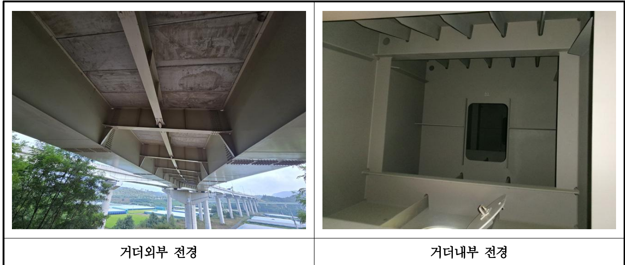
【사진 42.3.4】 거더 전경
